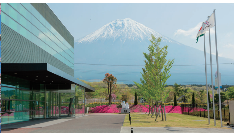
初夏・2号棟屋上からの眺め
