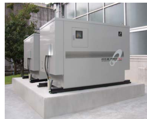
2台設置されている自社製の非常用ガス発電機。空調機器やマシンサーバーを守ります。
